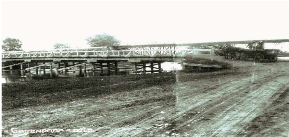
Die alte Holzbrücke vor der zerstörten Eisenbahnbrücke
