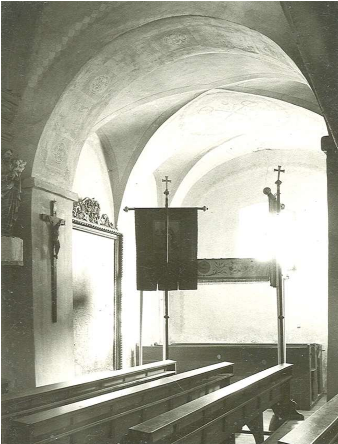
Photographie von Architekt Prof. H. Petermair vor Beginn der Umbauten 1978. Wo verblieb das kostbare barocke Altarbild „Hl. Dreifaltigkeit“ von 1698 ???
