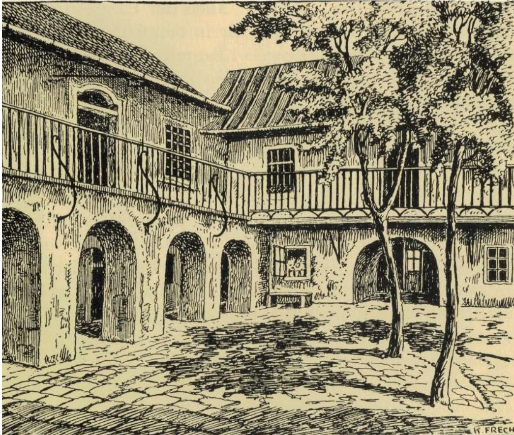
Innenhof des Kronenhauses
