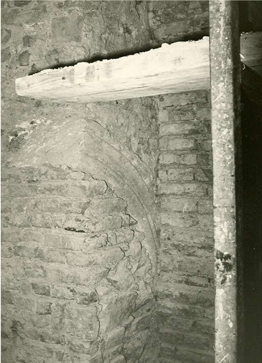
Freilegung eines romanischen Rundbogenfragments des ehemaligen Eingangs der Kirche an der Südwand anlässlich des Kirchengumbaus 1978
