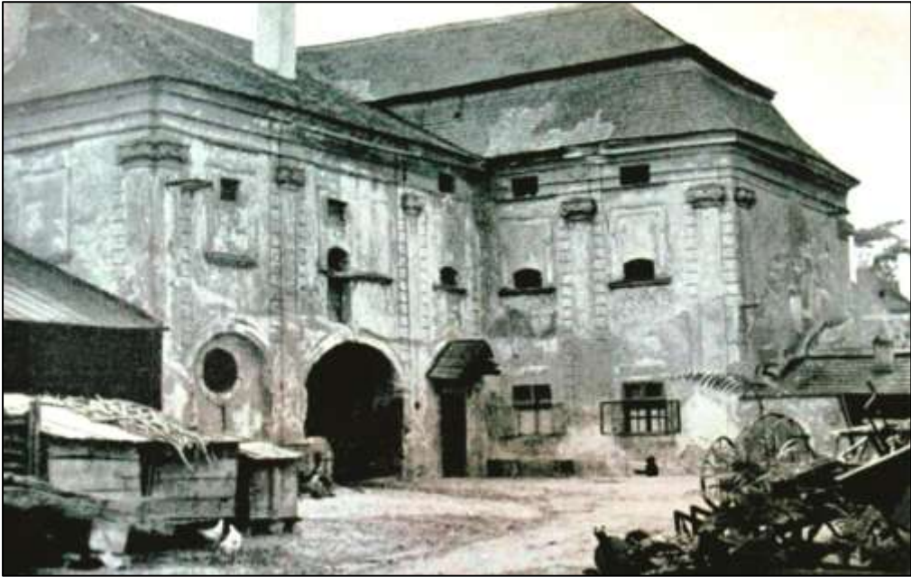
Altes Schloss, bereits zum Schüttkasten umgebaut, 1733 in Schloßberg'schem Besitz
