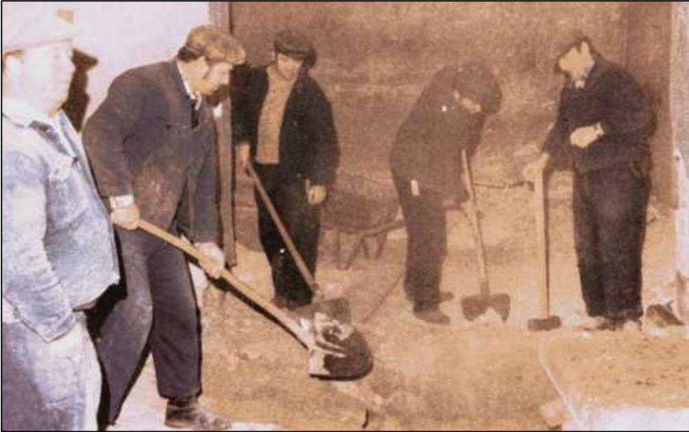
Zuschüttung der Gruft von Gräfin Barbara Esterházy und Gräfin Leopoldine Esterházy während der Renovierung der Pfarrkirche 1978
