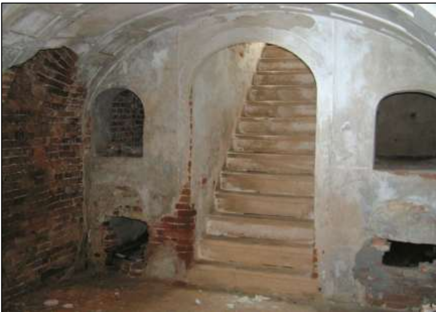
Krypta mit leider sehr durchfeuchteten Mauern beiderseits der Stiege sind Sargnischen erkennbar
