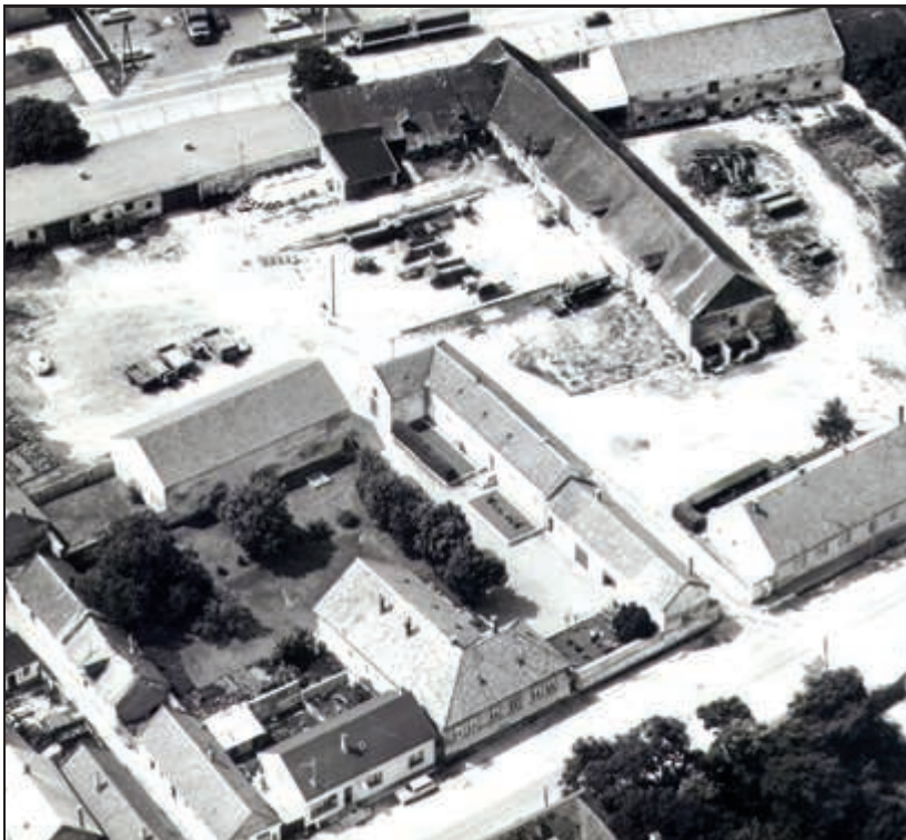
Unten: Luftaufnahme des Meierhofes; links unten erkennt man das neue Wohn- und Geschäftshaus von Johann Ranits.
