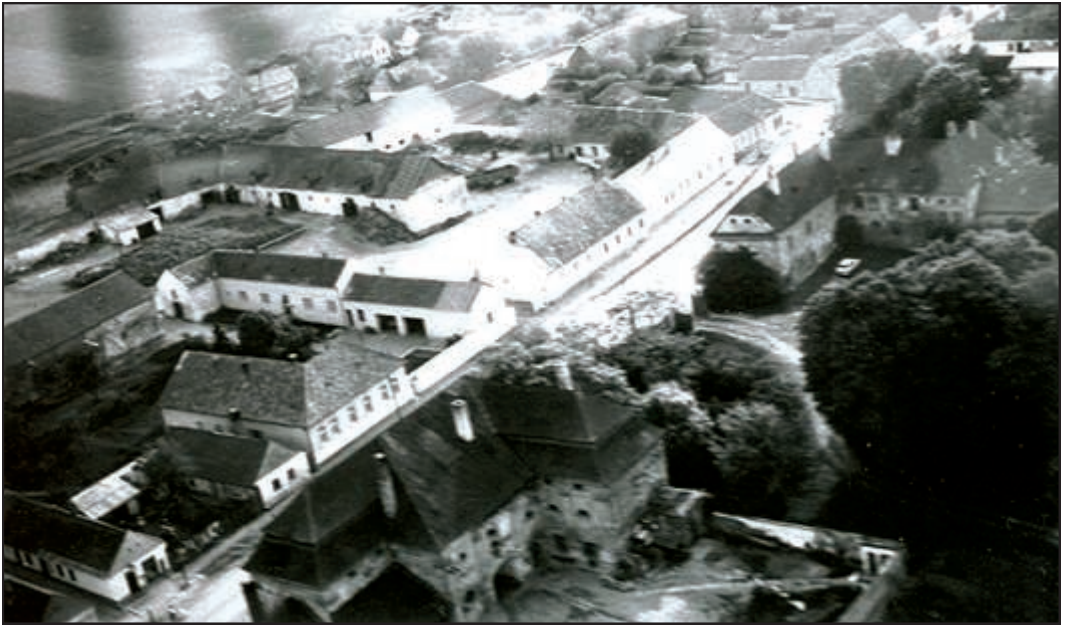
Oben: Luftaufnahme Altes Schloss, Neues Schloss, Meierhof, links unten altes Geschäftslokal von Johann Ranits.
