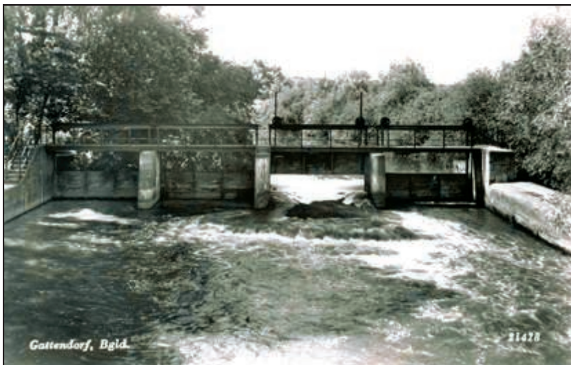
Stauwerk für den Antrieb der Turbine des Elektrizitäts- werks bei der Mühle.
