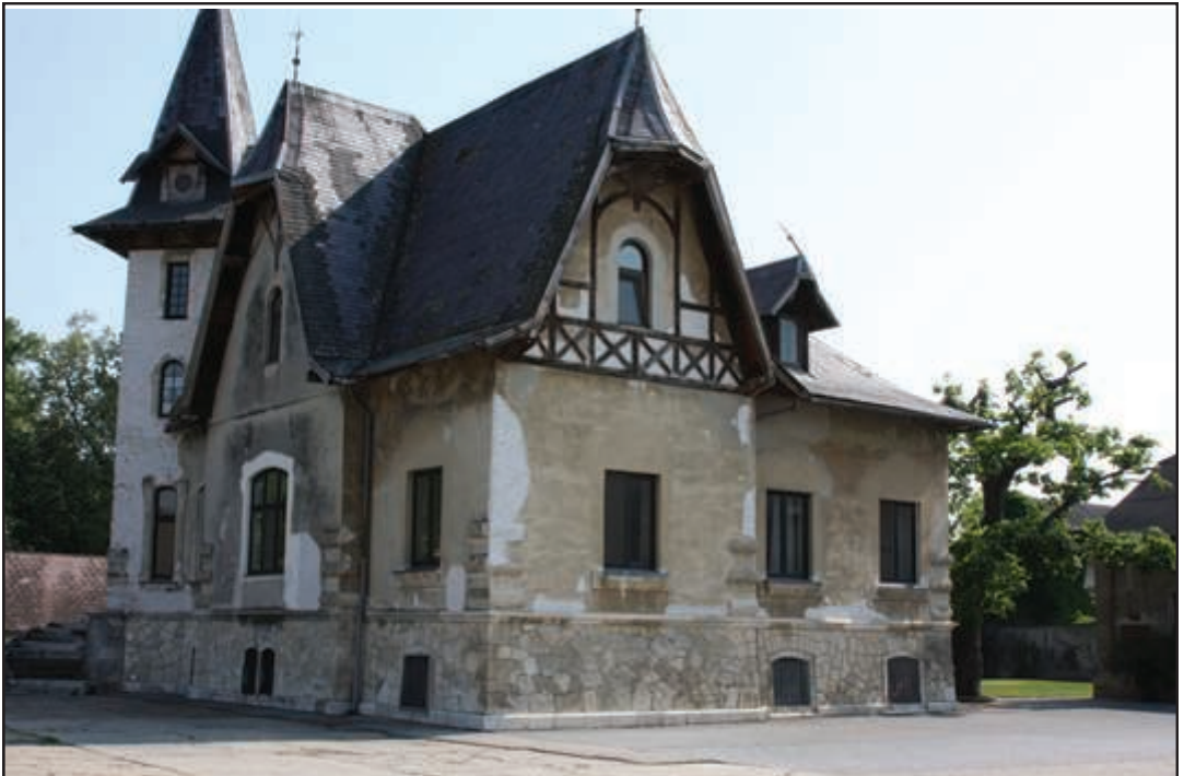
Unten: Villa, Zustand 2009.
