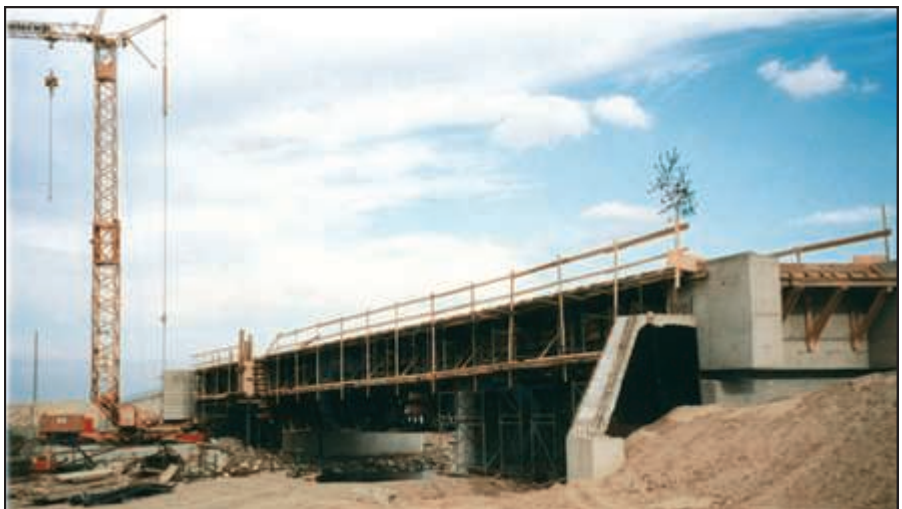
Bau der neuen Eisenbahnbrücke 1997/98.
