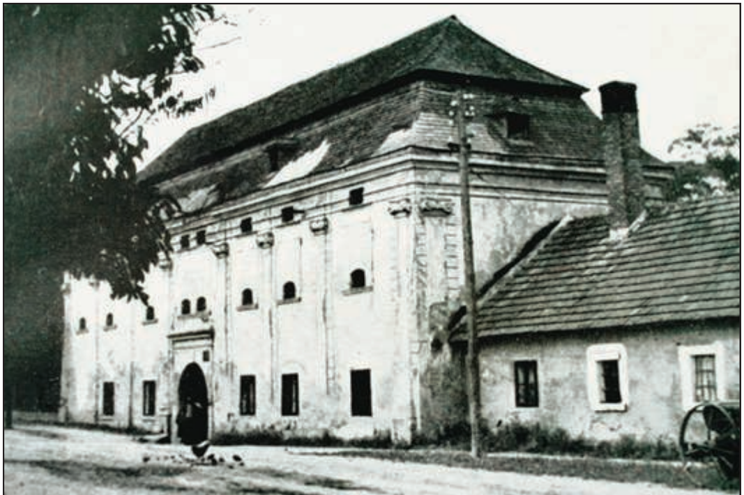
Unten: Altes Schloss/Straßenseite. Nach Einbau von Zwischenböden und Vermauern von Fenstern Nutzung als Schüttkasten.
