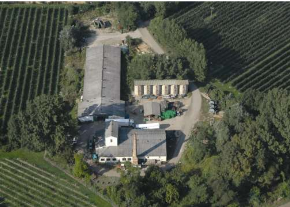
Luftaufnahme der Spiritusbrennerei mit danebenliegendem Ochsenmaststall und Futtersiloanlage
