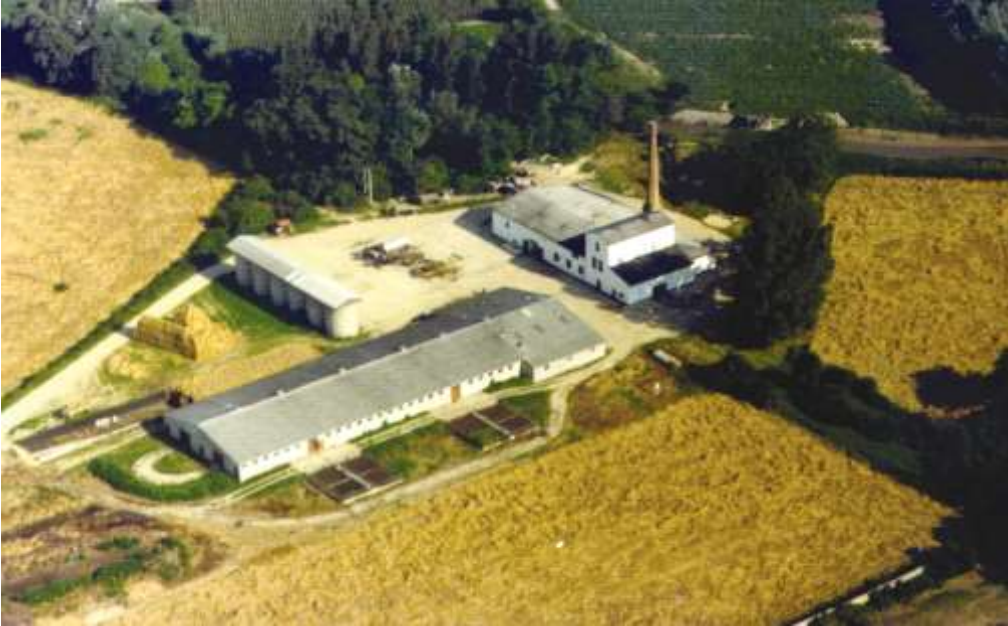
Luftaufnahme der Spiritusbrennerei mit danebenliegendem Ochsenmaststall und Futtersiloanlage
