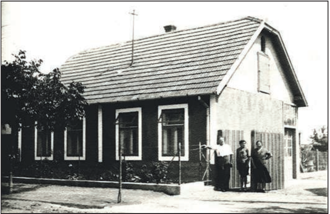
Oben und unten: Wohnhaus des Trafikanten Johann Milletich in der Bahnstraße, erbaut in der Zwischenkriegszeit. Die Bahnstraße bestand damals aus 4 Häusern, auf der rechten Seite Oberlehrer Bresich (1924/25) und links Leonhard Perl (1924/25), Johann Milletich und Fam. Kobor.
