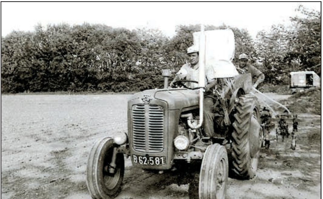
Unten: Traktorfahrer Josef Sommer. Bei der Maschine dürfte es sich um eine Einzelkornsämaschine handeln, die gleichzeitig den Kunstdünger einbringt.
