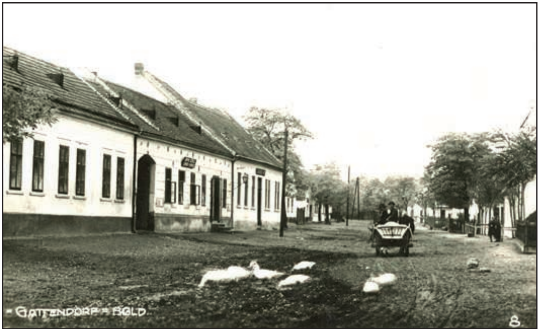
Oben: Wohnhaus der Fam. Karl Kremminger, danach Gemeindegasthaus und Gemeindeamt in der Unteren Dorfstraße.
