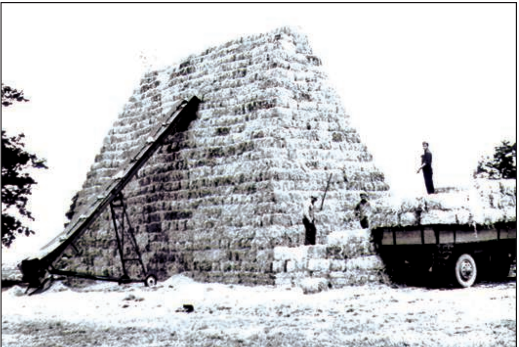
Unten: Errichtung einer Strohrüste.
