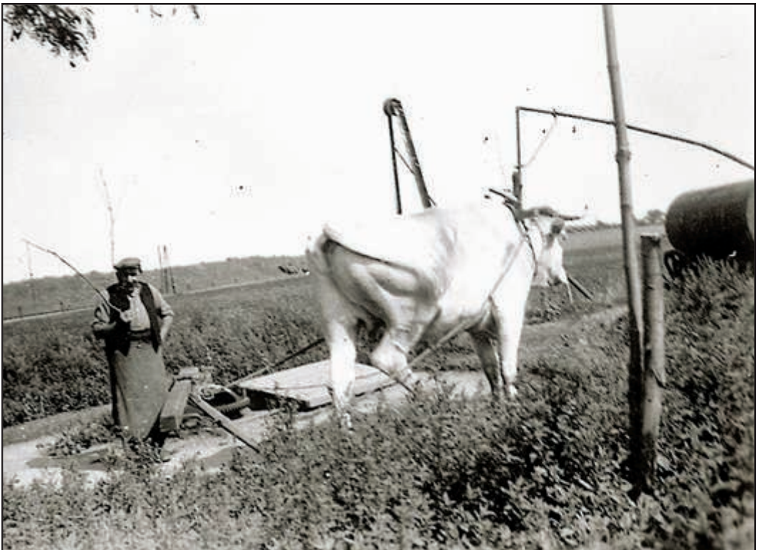
Unten: Niessl Josef (?) beim 30 m tiefen Brunnen auf der Siebenjoch. Ein Ochse treibt über einen Göpel eine Wasserpumpe an. Das große Fass auf dem Wagen (rechts im Bild) wird gefüllt.
