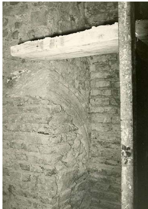
Freigelegtes römisches Türgewände
