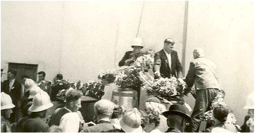
Vorbereitung zum Aufziehen der Glocken in den Turm. In der Mitte auf dem Wagen Zimmermeister Stefan Strasser
